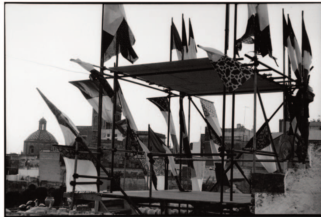
Tetto della Bottega G. Fasano, 1988
